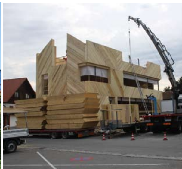
Bestehende Bausubstanz wurde kurzerhand in ein energieeffizientes Haus umgewandelt.
